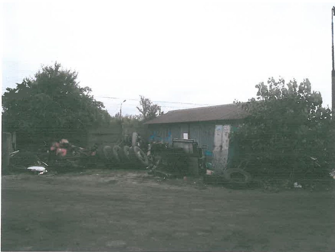
Widok na magazyn blaszany na wlocie do działki nr 302/48 oraz na budynek zaplecza socjalnego.
