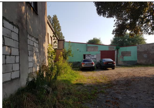
5.1) Budynek usługowy - nieczynny
