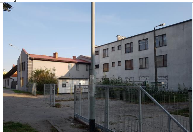
5.2) Budynek usługowy - nieczynny
