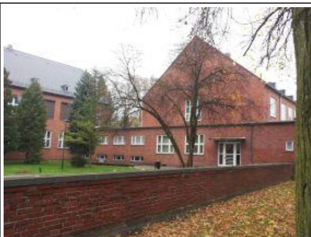
Fot. 2. Widok na zespół szkół ponad gimnazjalnych z ul. Marcinkowskiego
