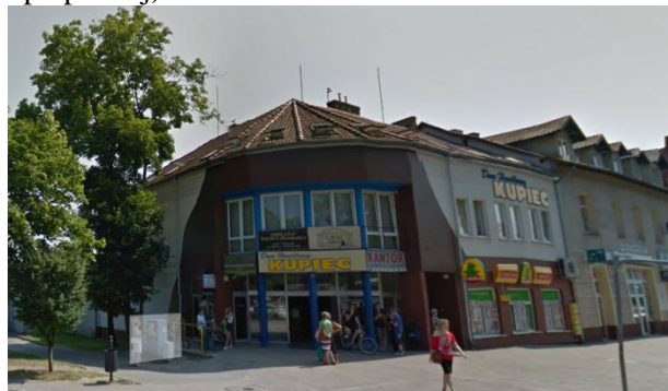
Ryc.4. Strefa wejściowa do Domu Handlowego „Kupiec” od strony narożnika al. Niepodległości i ul. Zwycięstwa.
